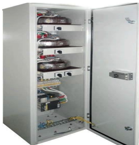
Рисунок 7 - Общий вид регулятора напряжения «БРИЗ-Р» (для справки)
